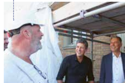
Voorman John geeft een rondleiding over de bouwplaats.
